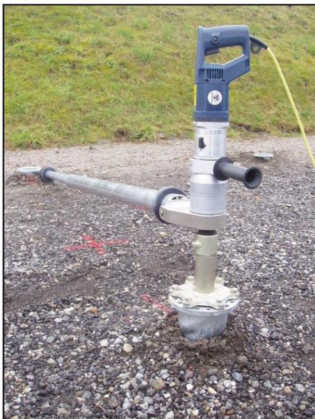
Die kleineren Fundamente lassen sich einfach mit dem Eindreh Schlüssel von Hand eindrehen. Dazu ist ein kompakter Boden erforderlich, da sich die Fundamente selber in den Boden ziehen. Bei steinigem Boden ist ein Vorlochen hilfreich.
